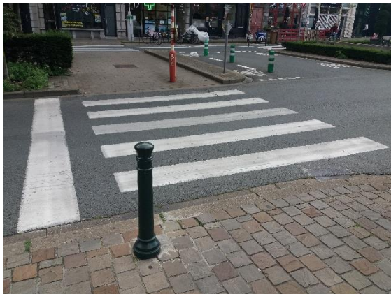
Figure 5 : Traversée piétonne et qualité du revêtement du trottoir à améliorer sur la place Albert – source : Traject
