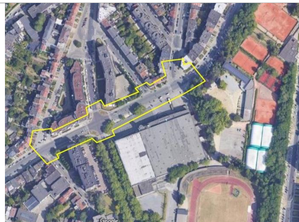
Figure 71 : Vue aérienne du périmètre du projet de la STIB (source : GoogleMaps, ill. CSD Ingénieurs)
