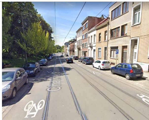
Photo 32 : Chaussée de Bruxelles, entre le chemin d'accès à la gare de Forest-Est et la rue des Abbesses (source : Google Maps, mai 2019)
