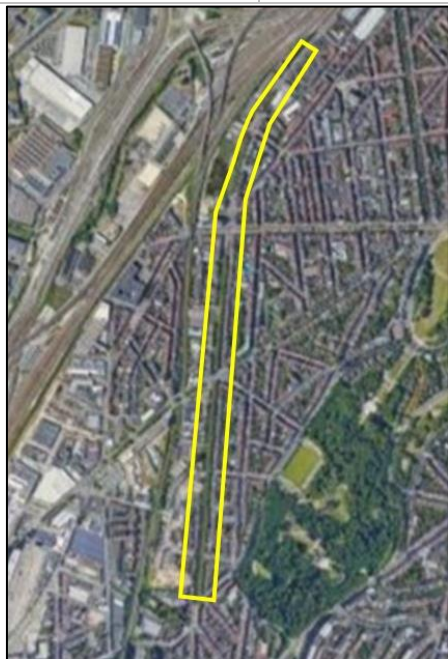
Figure 137 : Vue aérienne du périmètre de l'action
