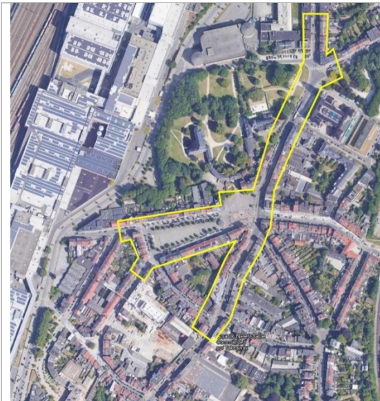
Figure 55 : Vue aérienne du périmètre du projet (source : GoogleMaps, ill. CSD Ingénieurs)
