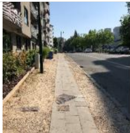
Photo 34 : Trottoir sur l'av. Rousseau (source : Projet de PCM, mars 2021)
