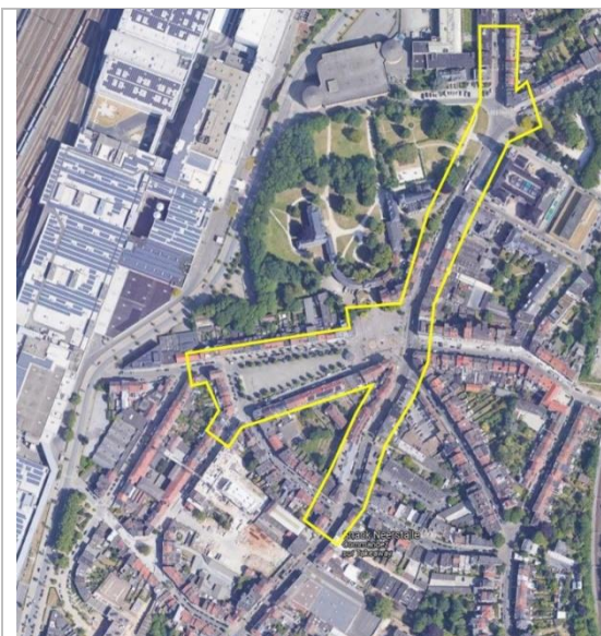
Figure 35 : Vue aérienne du périmètre du projet (source : GoogleMaps, ill. CSD Ingénieurs)
