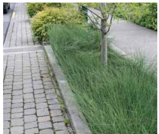
Référence de jardin de pluie le long d'une voie, en temps sec
