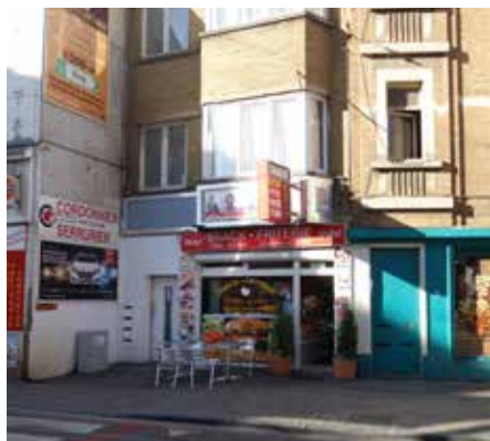
Liseré commerçant - Chaussée de Neerstalle - Forest
