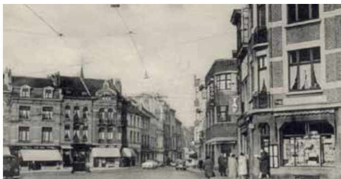
Chaussée de Bruxelles
