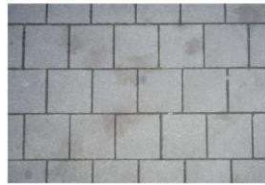
pavés béton - trottoir
