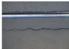
Asphalte avec rails - chaussée
