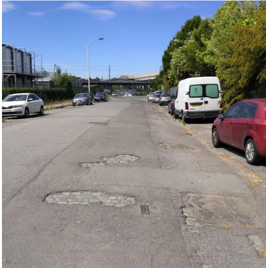
Photo 1 : Rue de la Soerie
