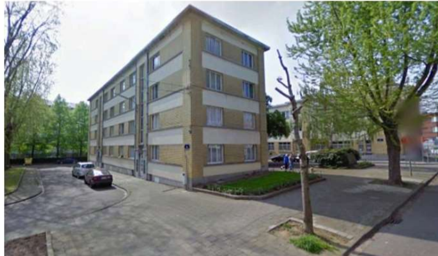
Figure 9: Tissu bâti - Nouvelle Cité (source : Google Street View)
