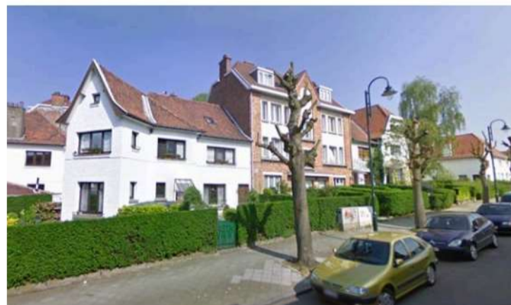
Figure 8: Tissus bâti - Cité Forest Vert (source : Google Street View)
