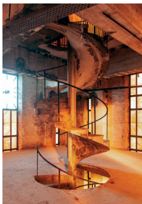
Zicht op een verdieping van de toren. A. de Ville de Goyet © urban.brussels, 2018
